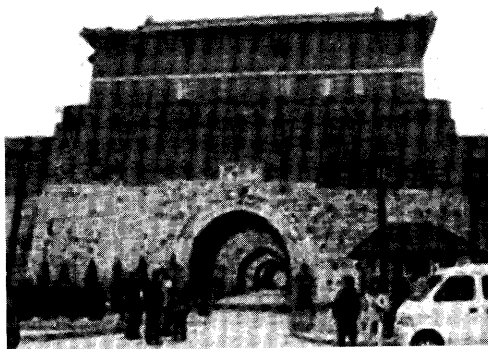
中華門は四層のトンネル状になっている （撮影／富澤繁信、平成16年3月）
